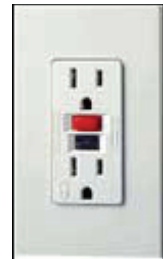
Receptacle Type (GFCI)
